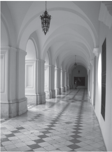
Fig. 4. Claustro do Colégio de Córdoba, com colunas, arcos e abóbadas originais, exceto o piso e bases de mármore revestidos no século XIX.
