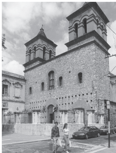
Fig. 10 Vista externa da igreja do colégio de Córdoba.
