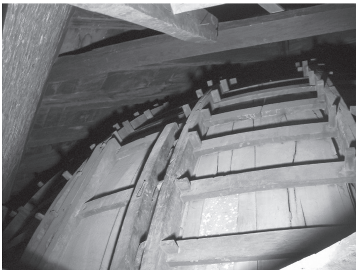
Fig. 11 Detalhe interior da cúpula construída com o sistema Delorme.
