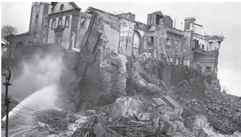
Fig. 8. Momento do desmoronamento do muro da igreja do colégio do Rio de Janeiro na demolição em 1922.
