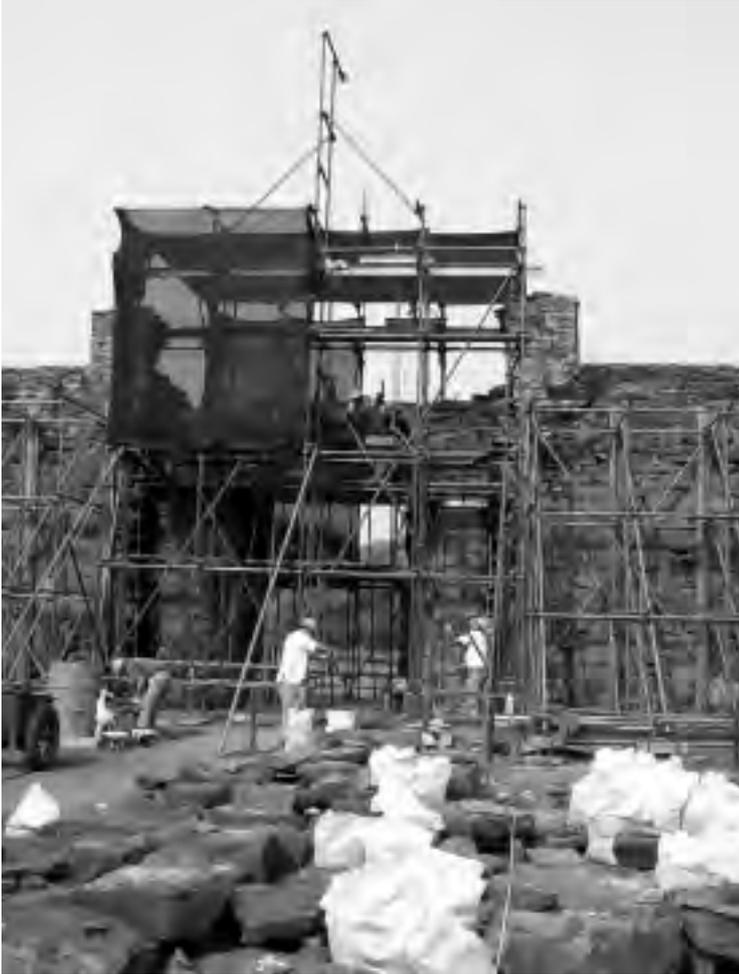
Foto N° 6: Vista del área de obra. Adelante los mampuestos removidos. Al fondo el andamio y el puente grúa.
