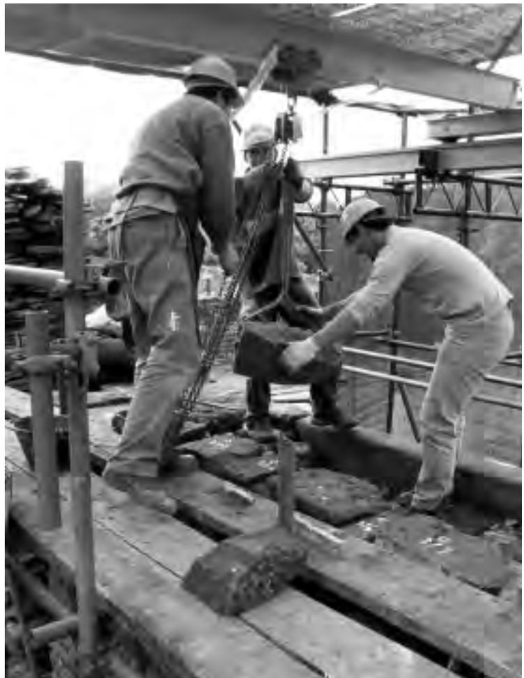
Foto N° 7: Recolocación de mampuestos durante el rearmado del muro.
