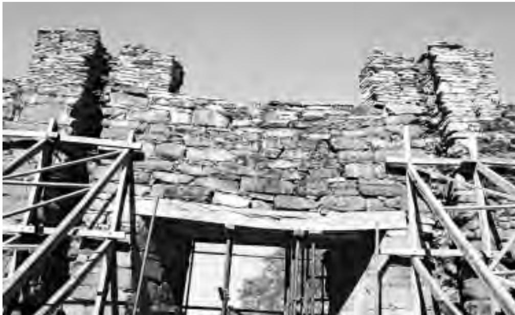
Foto N° 3: El dintel desde la nave del templo. Nótese la deformación de las vigas.
