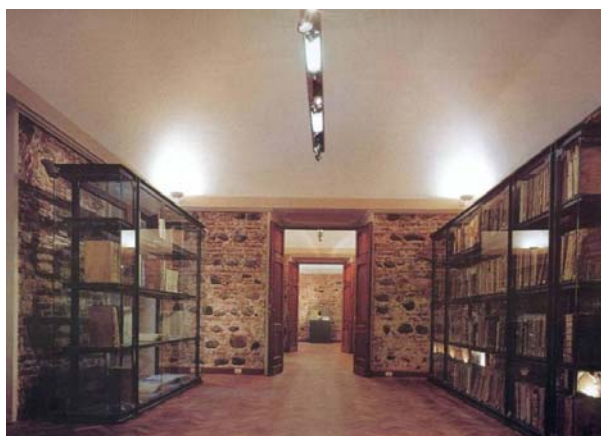
F. 7 Ex rectorado de la UNC, obra terminada e inaugurada 8/12/2000. Se descarnaron muros y se conservó el parquet sobre el piso original.
