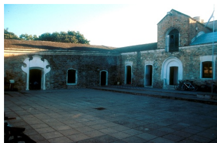
Fig. 11 Vista actual del patio del obraje.
