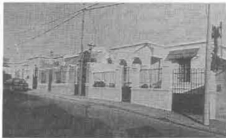
En las cercanías del observatorio, sobre la calle Paso de los Andes, entre Duarte Quirós y Bv. San Juan, se comenzó en 1918 con ocho casas. Aún se conservan casi intactas, sobre ambas aceras, diferenciándose dos modelos de unidades habitacionales.
