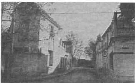
Entre 1921 y 1925 se construyeron las primeras casas de San Vicente, proyectadas por el arquitecto Juan Kravtch. En la actualidad ninguna conserva su porie original, no obstante en el conjunto se pueden apreciar los diseños y volúmenes ornamentales que las destacarán del resto de las viviendas para obreros.
