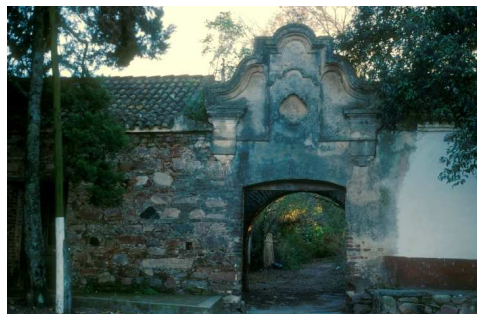
Fig. nº8: Ingreso al zaguán de la ranchería de Santa Catalina.
