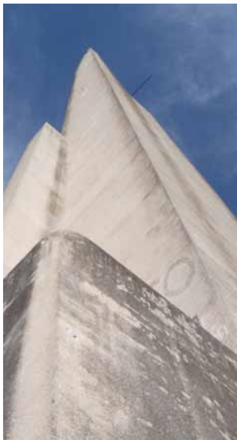
Vista de la esquina noroeste del monumento.
