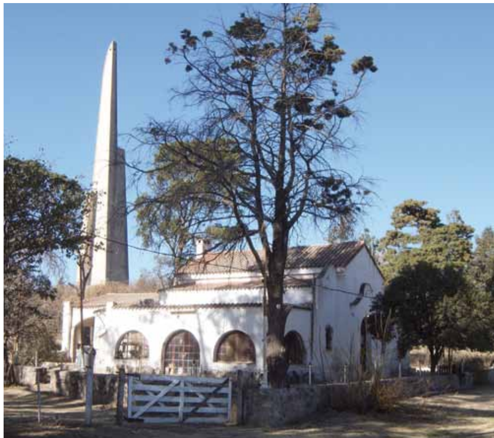
Edificio destinado a escuela ubicado junto al monumento, hoy abandonado.
